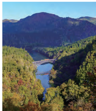
JR只見線(第一只見川橋梁)
